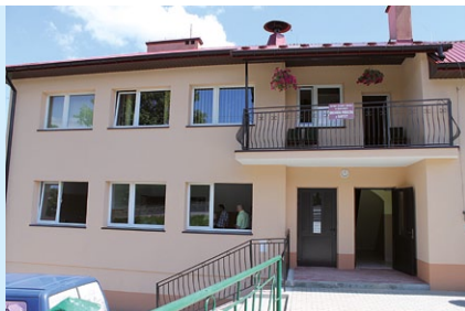
Odnowiony budynek Domu Ludowego w Baryczy
