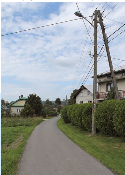
Droga Budzisz z oświetleniem
