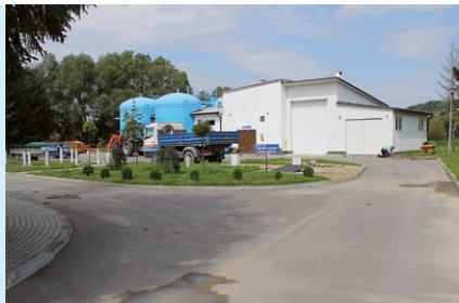
Oczyszczalnia ścieków w Domaradzu
