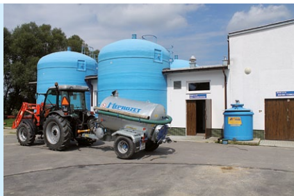
Oczyszczalnia ścieków w Domaradzu
